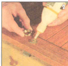
2 Замок вставляют в отверстие с тыльной стороны двери, выверяют и крепят шурупами (предварительно наколов или просверлив под них отверстия) на внутренней стороне двери. С лицевой стороны край отверстия укрывают декоративным кольцом. Для надежности его можно посадить на клей.
